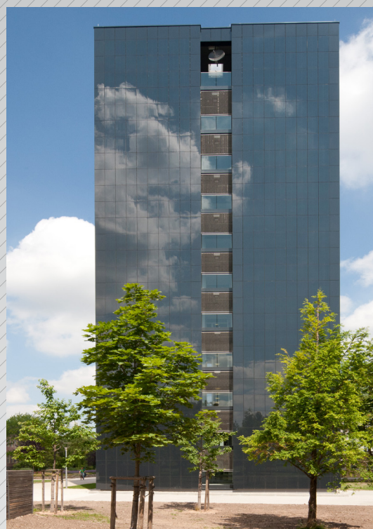
Im Zuge der Modernisierungsarbeiten im Hochhaus der Uni Erfurt wurde der Senatssaal medientechnisch neu konzipiert.
